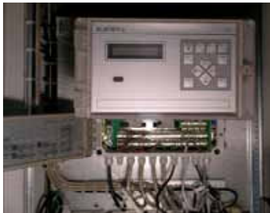
УСПД RTU-325 с открытой крышкой клеммного отсека
